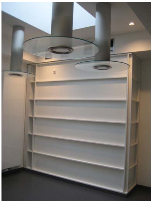
Cafeteria: 4 Düsenplatten mit Umluftfilteranlage 2 x SC 1000 UL im Sonderdesign (links)
