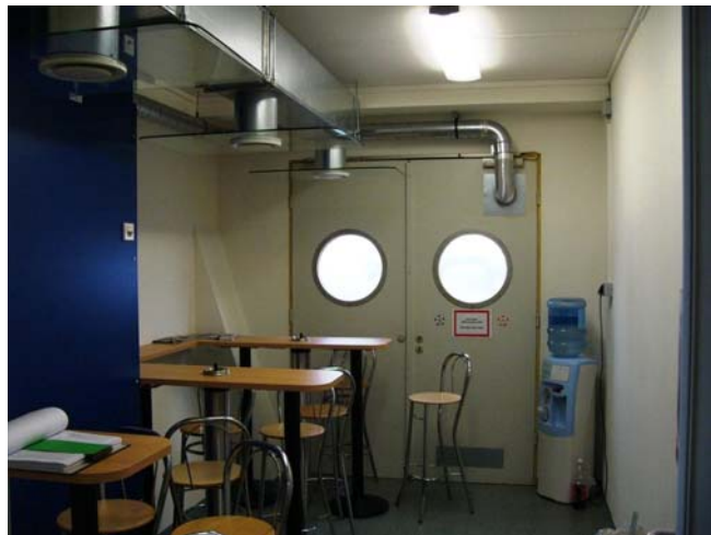
Raucherraum: 3 Düsenplatten mit Lang-Stehtischen für 15 Raucher mit Umluftfilteranlage SC 1500 UL (oben)
