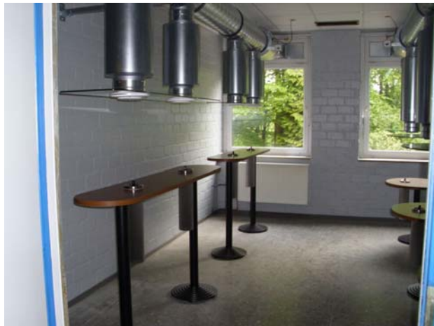
Behinderten-Zentrum: 2 Doppel-Düsenplatten mit Stehtischen und 3 Einzeldüsenplatten mit Sitztischen für Rollstuhlfahrer (oben).
